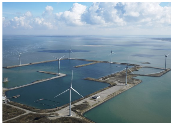
Windpark Bouwdokken, Oosterscheldekering
